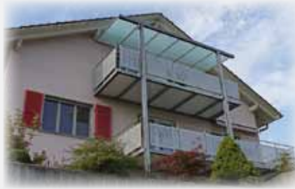
Balkonanlage mit Verglasung
