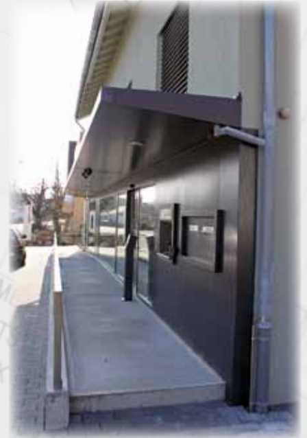
Metallfassade mit Vordach
