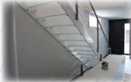
Innentreppe mit Glasritten
