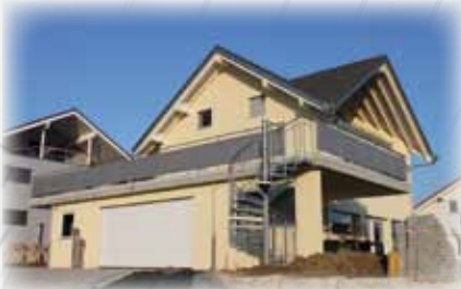
Ausstertrepp mit Geländeranlage
