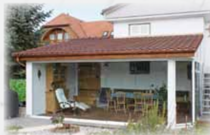
Wintergarten unisoliert mit Ziegeldach
